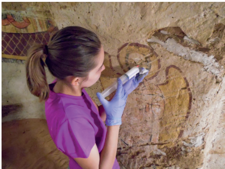
Filling the void between detached plaster and the wall with mineral injection fluid in church NB.2 / Wypełnianie odspojień przy pomocy zastrzyku z płynu mineralnego w kościele NB.2 (phot./fot. E. Michalik)
