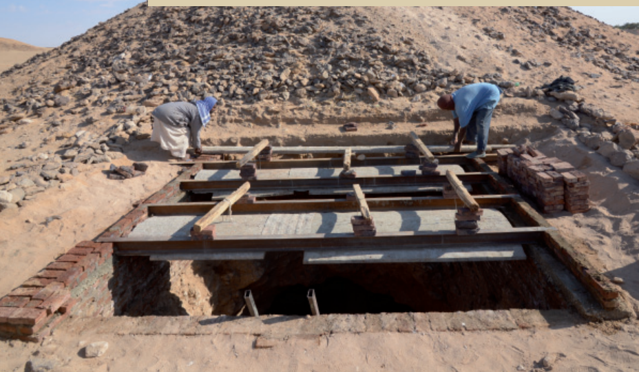
El-Zuma. Tumulus T.4. Construction of a protective roof over the external shaft of the underground tunnel; the completed roof on the right / Założenie osłaniającego dachu nad zewnętrznym szybem prowadzącym do tunelu w grobowcu T.4: po prawej gotowe zabezpieczenie (phot./fot. A. Kamrowski)
