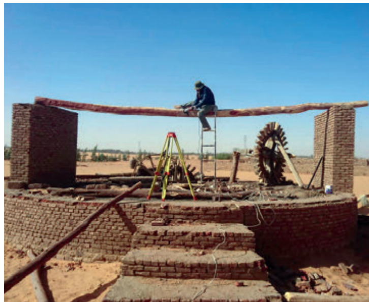
Selib 1. Mounting the vertical cogwheel of the saqia. February 2019 / Montaż osi głównego koła zębatego sakiji, luty 2019 r. (phot./fot. R. Łopaciuk)
