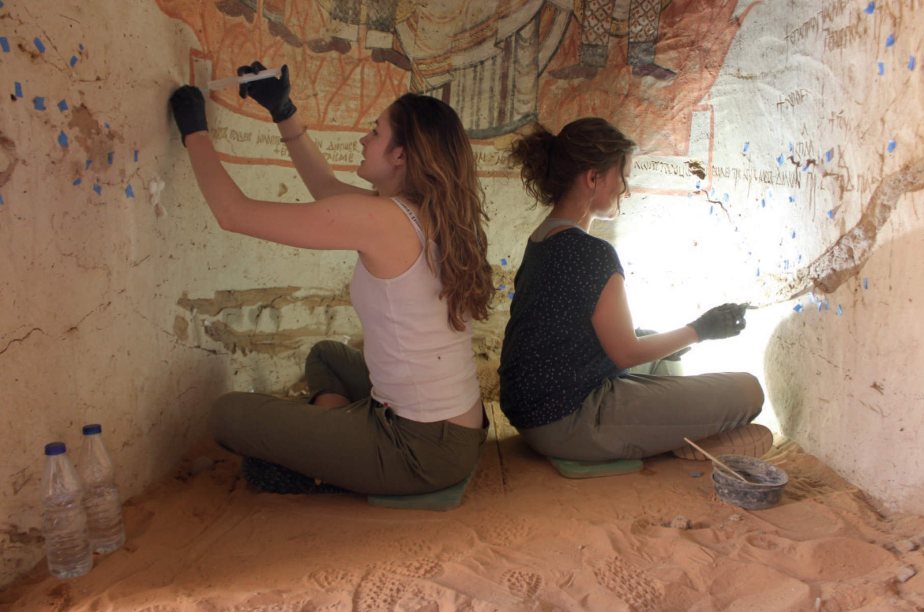
Strengthening plaster structure and applying putties in the NB.2 church in the scene of Three Youths in a Fiery Furnace / Wzmacnianie struktury tynków i zakładanie kitów w kościele NB.2 przy scenie Trzech Młodzianków w piecu ognistym (phot./fot. M. Skarżyńska)
