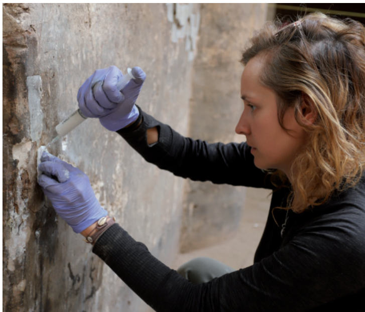
Injection of a consolidating substance into weak and detached plaster on the wall of the sanctuary in the Royal Church of Archangel Raphael / Zastrzyki konsolidujące słaby, odpadający tynk ze ściany w sanktuarium królewskiego kościoła pw. Archaniola Rafała (phot./fot. C. Calaforra-Rzepka)
