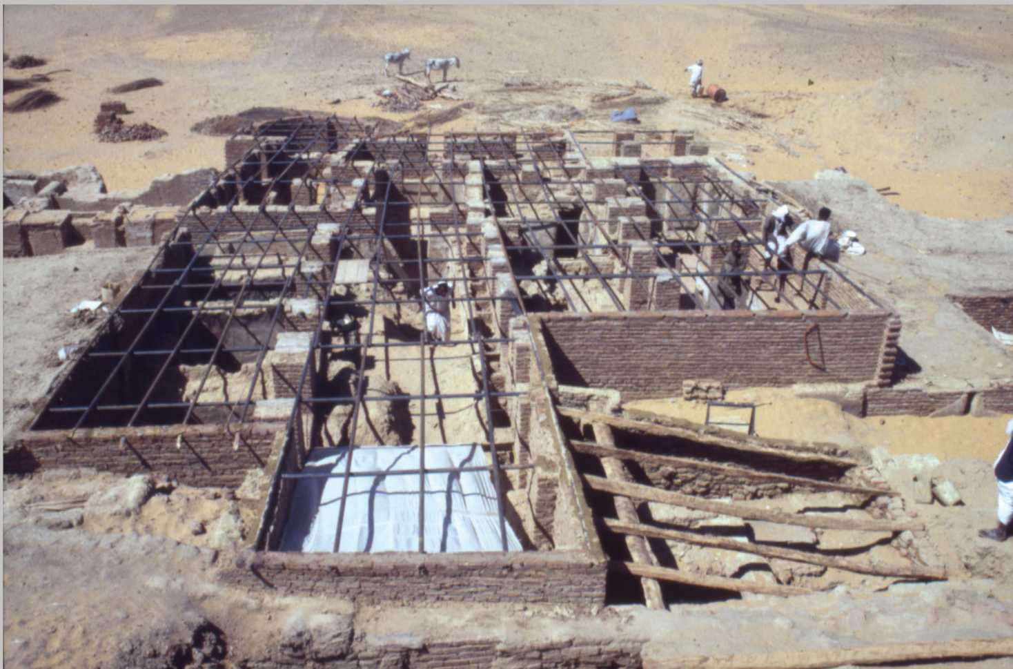
Construction of a framework for the palm rachis roof over the Northwest Annex of the Old Dongola Monastery on Kom H / Konstrukcja szkieletu dachu palmowego nad aneksem północno-zachodnim klasztoru na komie H (phot./fot. B. Żurawski)
