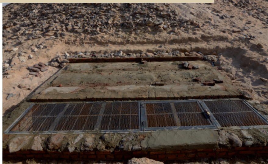
El-Zuma. Tumulus T.4. Construction of a protective roof over the external shaft of the underground tunnel; the completed roof on the right / Założenie osłaniającego dachu nad zewnętrznym szybem prowadzącym do tunelu w grobowcu T.4: po prawej gotowe zabezpieczenie (phot./fot. A. Kamrowski)
